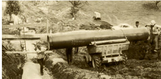
Рис. 3. Фотография стеклопластиковой трубы, изготовленной в 1961 г.
